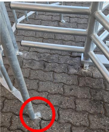
Montieren Sie dann den Schirm weiter auf der Oberfläche, indem Sie die restlichen Bohrlöcher mit einem chemischen Dübel befestigen. Stellen Sie sicher, dass sie in einer geraden Linie stehen.
